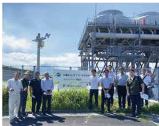
参加者で開開岳もバックに集合写真 ＝九電みらいエナジー山川発電所
