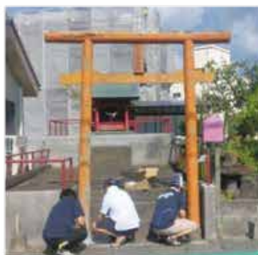
経年劣化でオレンジ色に
