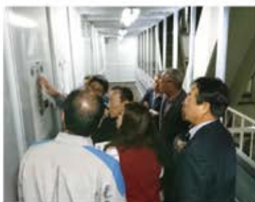
担当者より説明を聞く＝九州電力（株）苓北発電所
